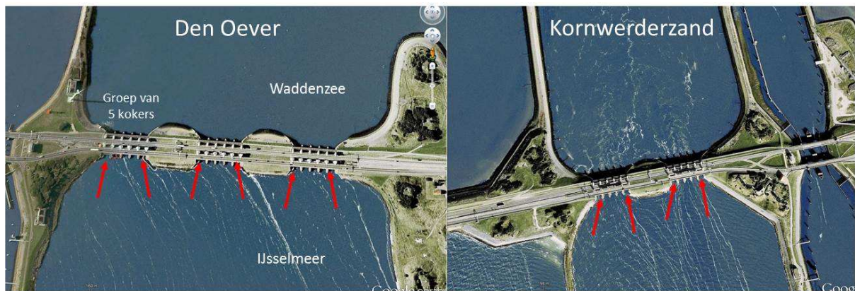
Figuur 2-2. Kaartjes met de spuicomplexen bij Den Oever en Kornwerderzand. Den Oever heeft drie groepen van vijf spuikokers en Kornwerderzand heeft twee groepen van vijf spuikokers. Bij de buitenste schuiven van elke groep van spuikokers (rode pijlen) kan aangepast spuibeheer worden toegepast (paragraaf 2.1.2), waarbij de schuiven op een kier worden gezet. Een kier wordt gecreëerd doordat de schuiven maar gedeeltelijke worden opengezet en er een kleine ruimte ontstaat tussen de onderkant van de schuif en de bodem (zie Figuur 2-5).
