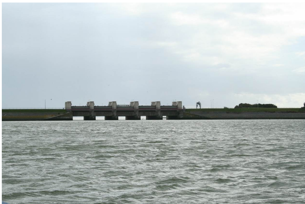
Spuisluizen bij Kornwerderzand tijdens het spuien bij laagwater (foto Ingrid Tulp)
