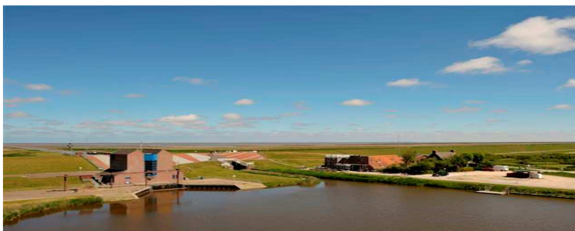
De sluis en gemaal bij Noordpolderzijl. Het gemaal wordt inmiddels passeerbaar gemaakt voor trekvissen. FOTO: Herman Wanningen
