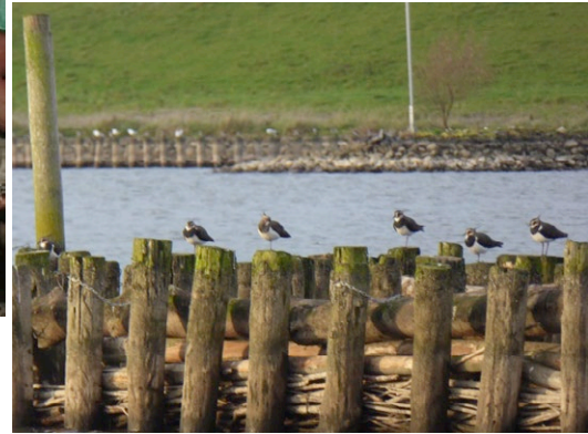
Barrière van hout in de Lek waarbij gewerkt is met een combinatie van rijshout en boomstammen
