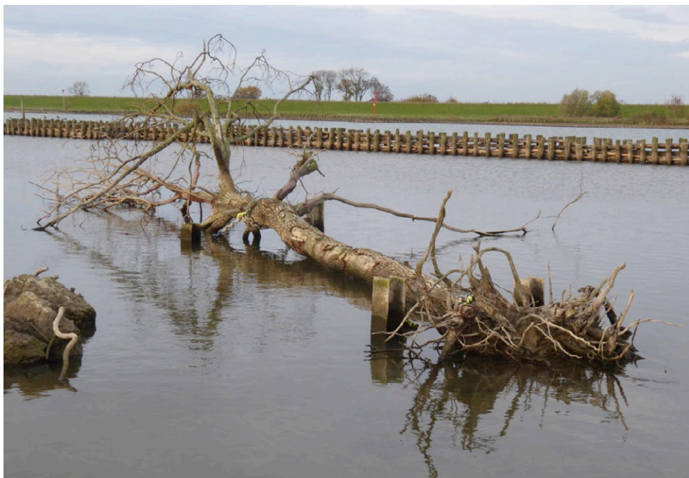
Barrière van hout in de Lek waarbij een complete boom (wortels, stam en kroontakken) gefixeerd is op de rivierbodem. Bij normale waterpeil ligt de boom grotendeels onderwater.
