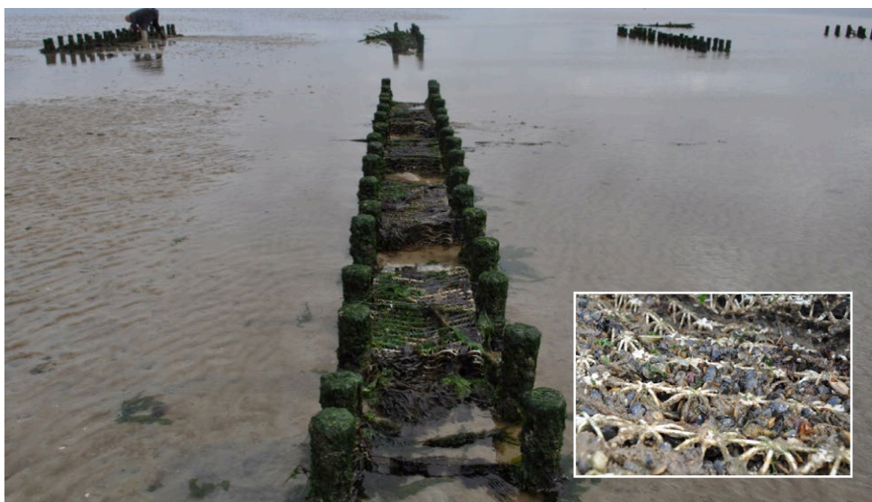
Barrières van biologisch afbreekbare kratstructuren tussen houten palen op Ameland waarbij mosselbanken op de kratstructuren ontstaan (inzet).
