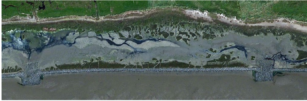
Luchtopname van golfbrekende stortsteenbarrières met openingen evenwijdig aan de kustlijn van Terschelling ter hoogte van de Wierschuur - Oosterend.
