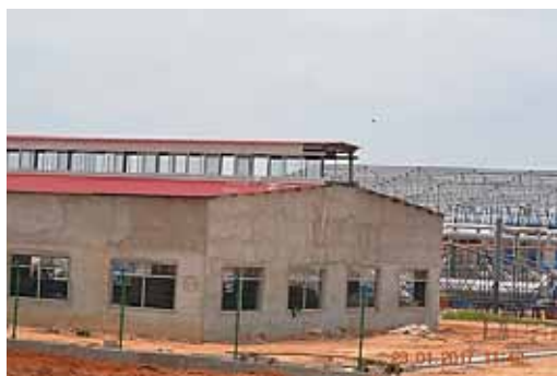
Vue partielle de l'usine de farine de poissons en construction (PHOTO 1)
