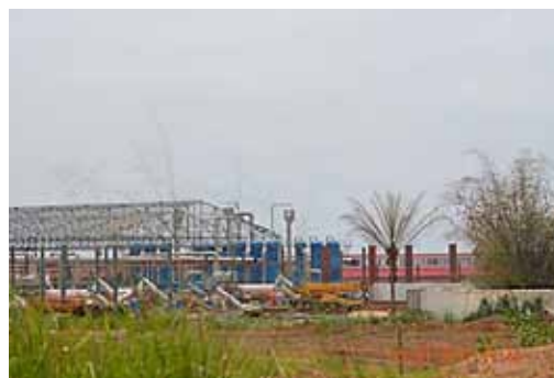
Vue partielle de l'usine de farine de poissons en construction (PHOTO 2)
