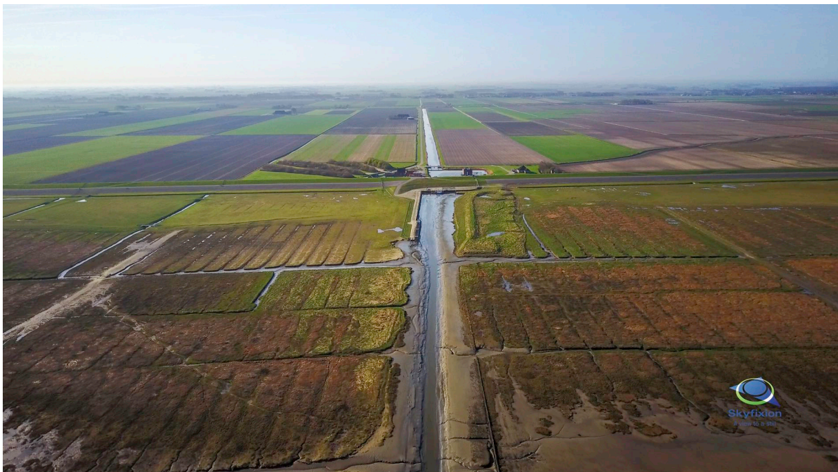
Afbeelding 1. Zicht op de haven van Noordpolderzijl, kijkrichting vanaf zee (© Skyfixion, april 2018).
