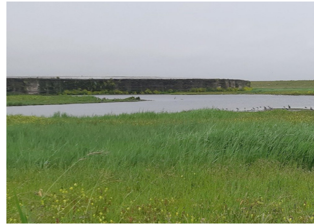
Artificieel vogelbroedeiland en hoogwatervluchtplaats bij Den Helder gemaakt van hergebruikt slib. Henk Volkers i.s.m LAMA landscape architects
