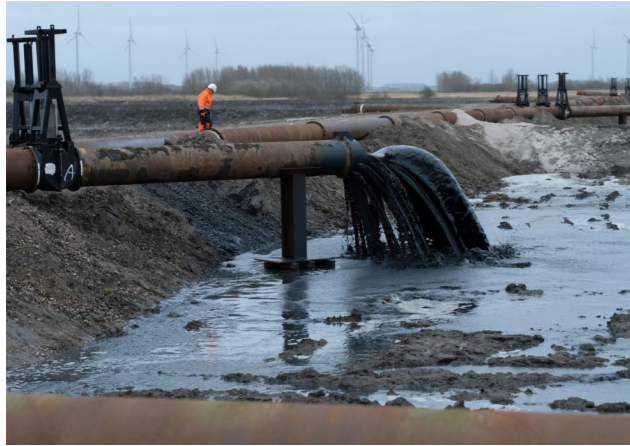
Slib opbrengen met pijpleiding in percelen met ringdijkje. beeld kleirijperij; bron: Christiaan van Velzen
