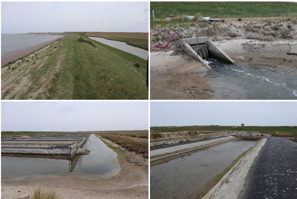
Figuur 2.1 Enkele foto's van het veldbezoek aan Polder Wassenaar. Linksboven: zicht op het zuidelijke deel van Polder Wassenaar met links de Waddenzee en rechts de polder. Rechtsboven: de uitgang van het hevelsysteem: bij opgaand tij stroomt het water via dit hevelsysteem van de Waddenzee naar de kweekbassins. Linksonder: de hoogwaterbuffer aan de westzijde van de kweekbassins. Rechtsonder: één van de kweekbassins (raceways) waarin de kokkelteelt plaatsvindt.
