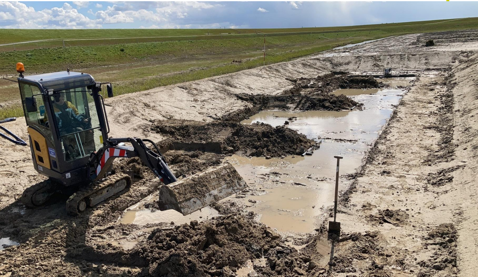
De vijver wordt aangelegd met een graafmachine
