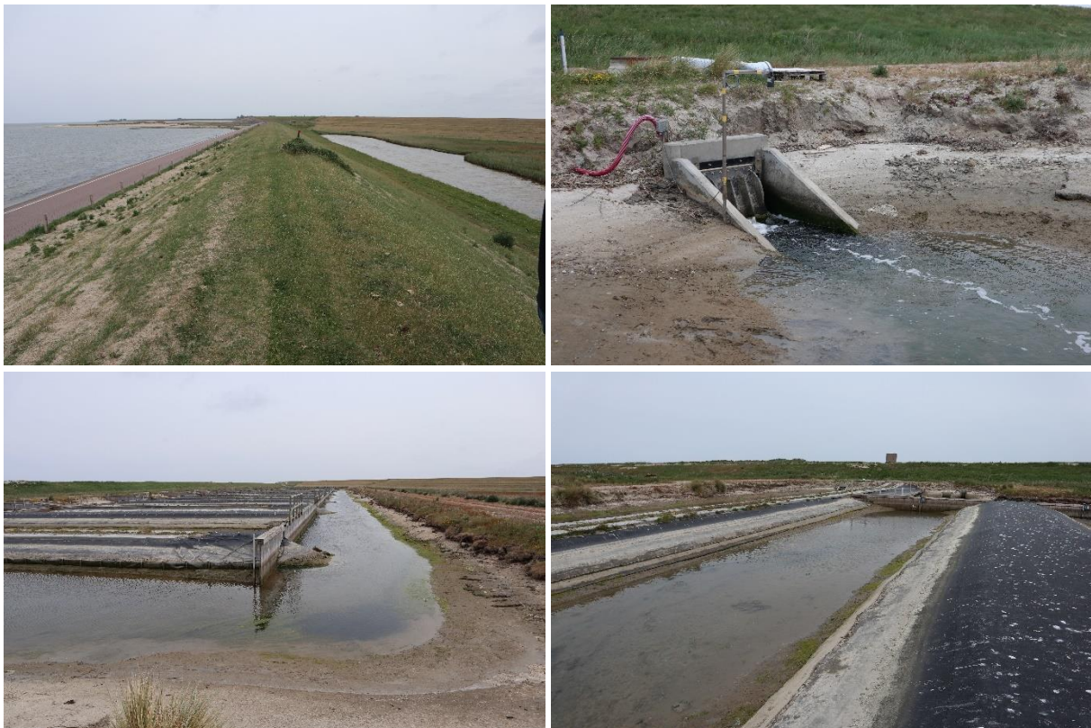
Figuur 3.1 Enkele foto's van het veldbezoek aan Polder Wassenaar. Linksboven: zicht op het zuidelijke deel van Polder Wassenaar met links de Waddenzee en rechts de polder. Rechtsboven: de uitgang van het hevelsysteem: bij opgaand tij stroomt het water via dit hevelsysteem van de Waddenzee naar de kweekbassins. Linksonder: de hoogwaterbuffer aan de westzijde van de kweekbassins. Rechtsonder: één van de kweekbassins (raceways) waarin de kokkelteelt plaatsvindt.
