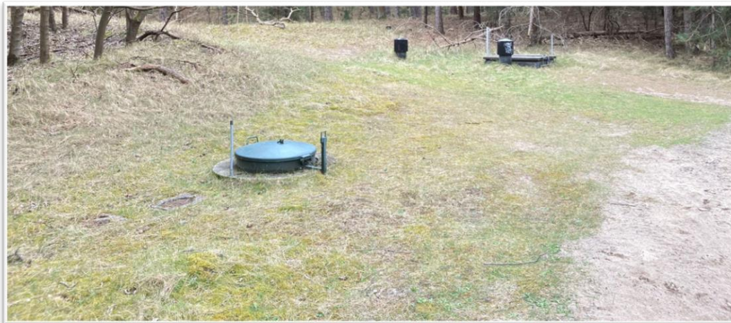
Figuur 18 - Waterput in de duinen van Schouwen. Waterwinning is op veel plaatsen langs de Hollandse kust een grote factor.
