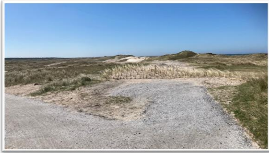
Figuur 17 - Op Vlieland lag het fietspad kort achter de zeereep. Deze is verlegd, zodat er geen overlast is door verstuiving.
