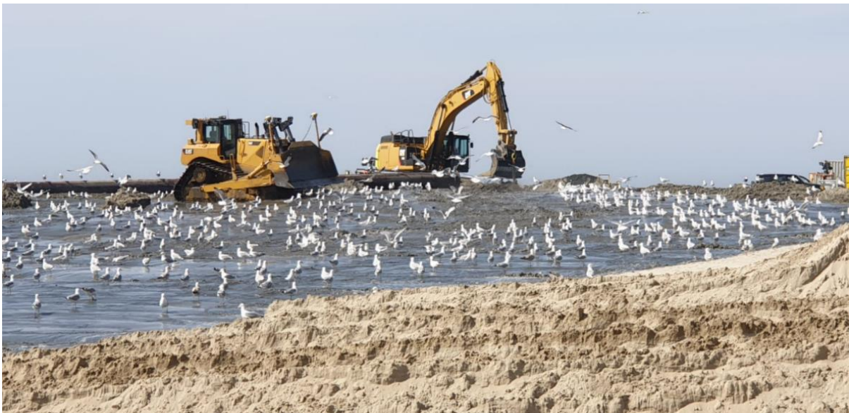
Figuur 35. Strandsuppletie ter hoogte van de Hoornderslag, Texel, 2021 (Foto A.P. Oost).
