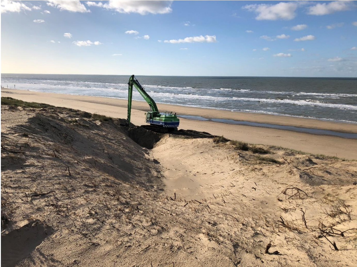
Figuur 60. Aanleg van één van de Zeven Broeders, Noordvoort (Foto M. Wiltink, Waternet).
