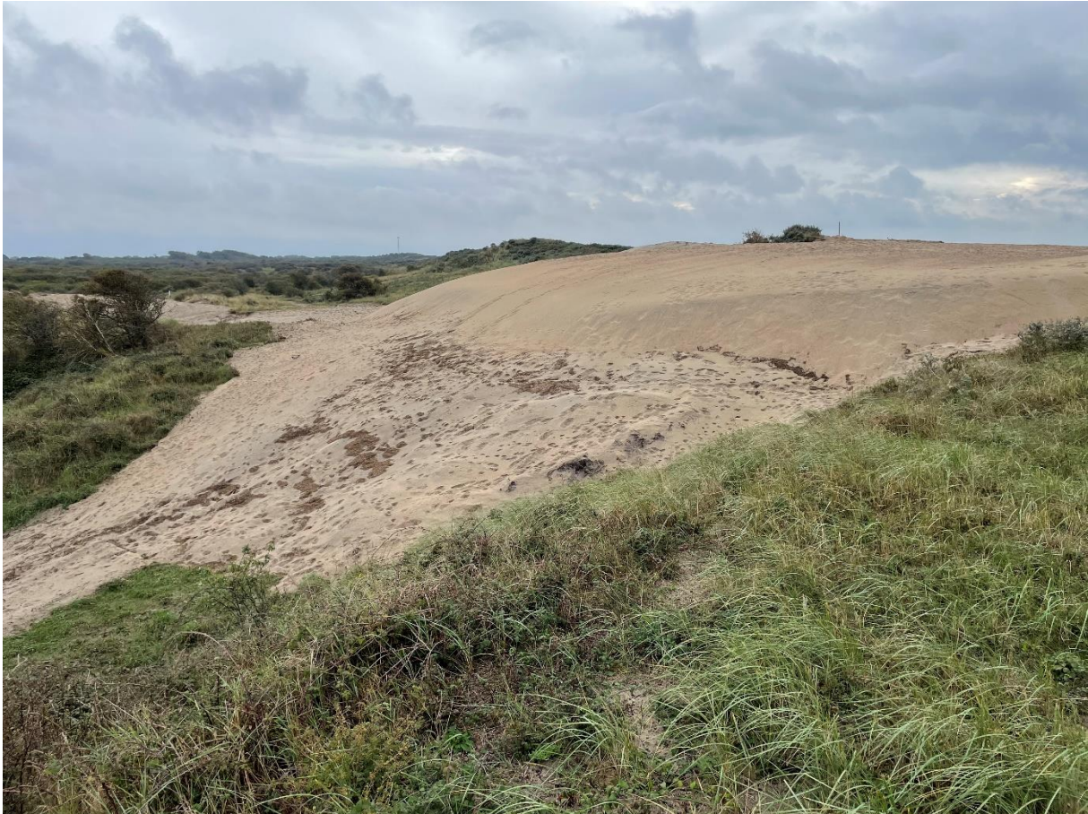
Figuur 57. Lijzijde van een kunstmatige kerf in de Springertduinen, Goeree, waarbij het zand uit de kerf naar achteren is geschoven. Het naar achteren geschoven zand neemt een natuurlijke hellingshoek aan (Foto B. Arens).
